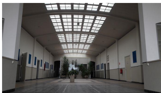
De gebogen lichtstraat aangebracht bij verbouwing 1952
